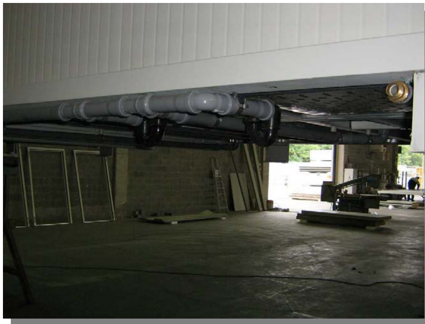
Vista collegamento tubazione di scarico monoblocco
